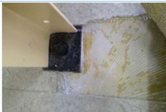
20 | Betonen vloer onder vloerzeil
