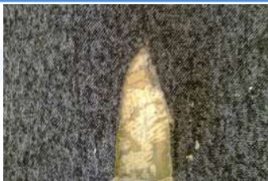
16 | Betonen vloer onder vloerbedekking
