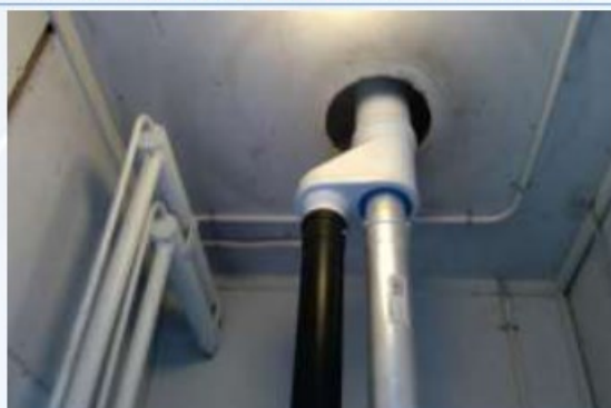
7 | Plaatmateriaal wand/plafond in cv ruimte
