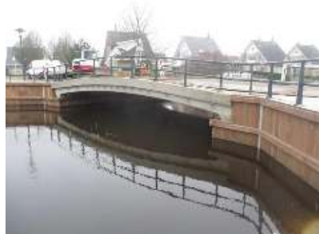
KW229 Betonbrug Bytling
