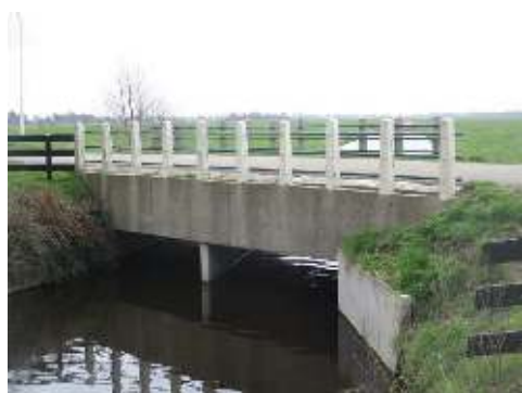
KW175 Betonbrug Boarnsweachsterdyk 1
