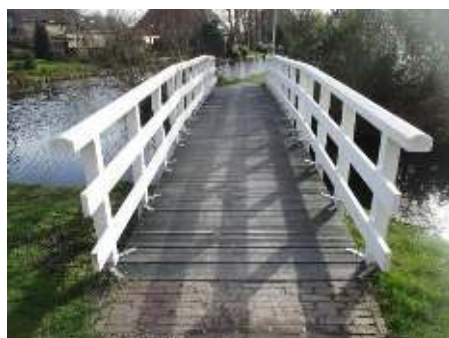
KW010 Fietsbrug Flinkeboske
