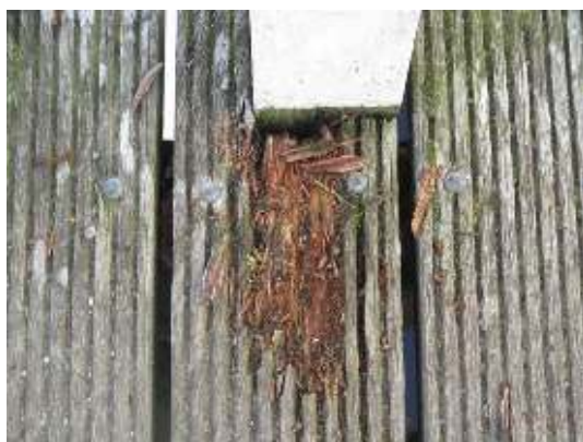
KW144 Brug Turfkoer
