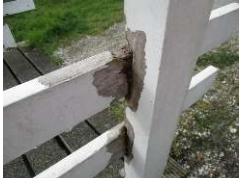
KW092 Brug Stjoerboard
