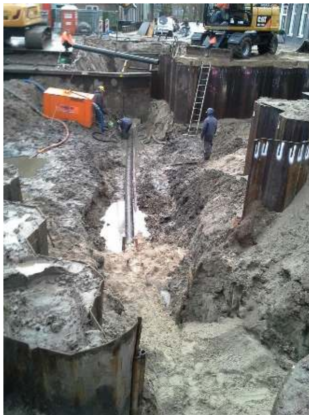
Vervangen van een zinker in de Kolk in Joure
