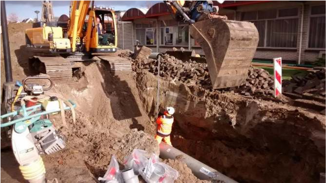
Rioolvervanging in de Kade in Sint Nicolaasga
