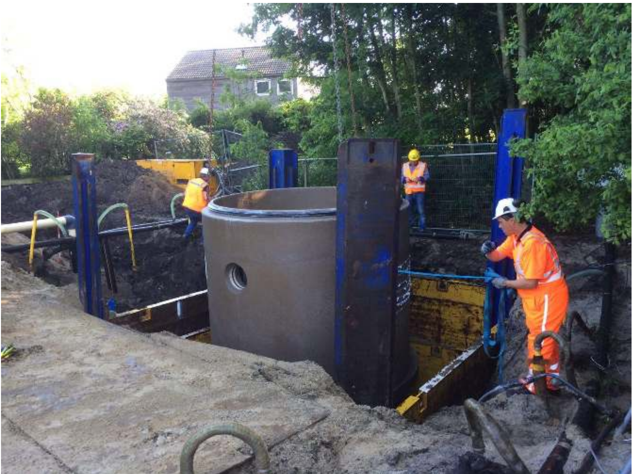
Vervangen rioolgemaal Brekkenweg Lemmer
