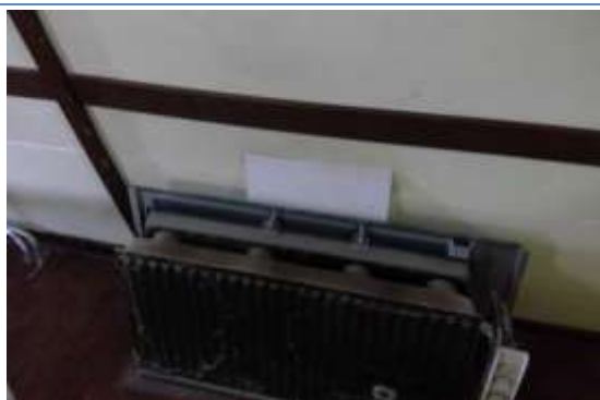
3 | Plaatmateriaal achter gevelkachel
