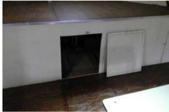
10 | Inspectie onder podium
