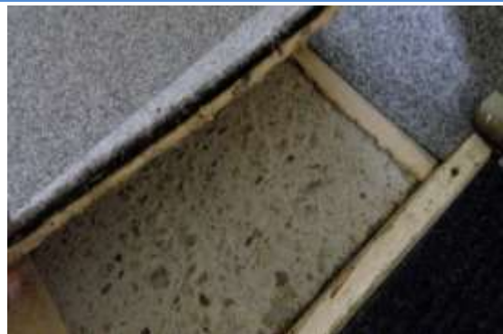
14 | Inspectie onder vloerbedekking
