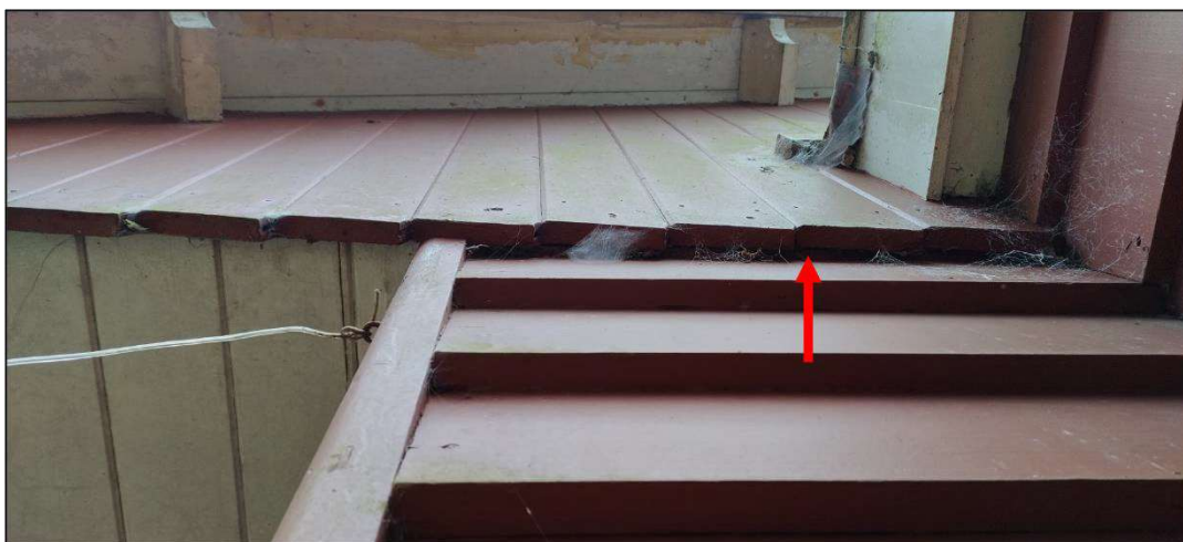
Figuur 2.2. Een voor vleermuizen geschikte doorgang achter gevelbetimmering.
